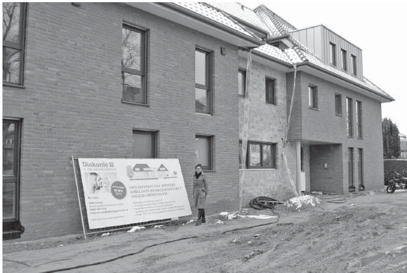
Jennifer Dumont, Leiterin der neuen Pflege-WG in Herzebrock-Clarholz, vor dem Neubau mit seiner traditionell gefertigten roten Ziegelfassade.
